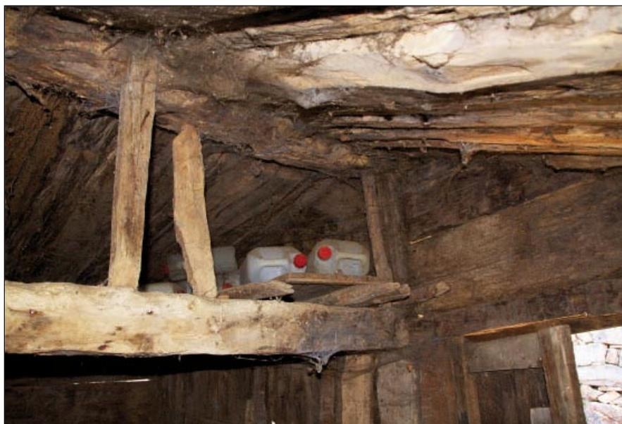
• Detalle interior del hastial de la cara NO. El vano entre la viga'l quesu o cruceta y el cumbral aparece reforzado con frecuencia con tornapuntas.
