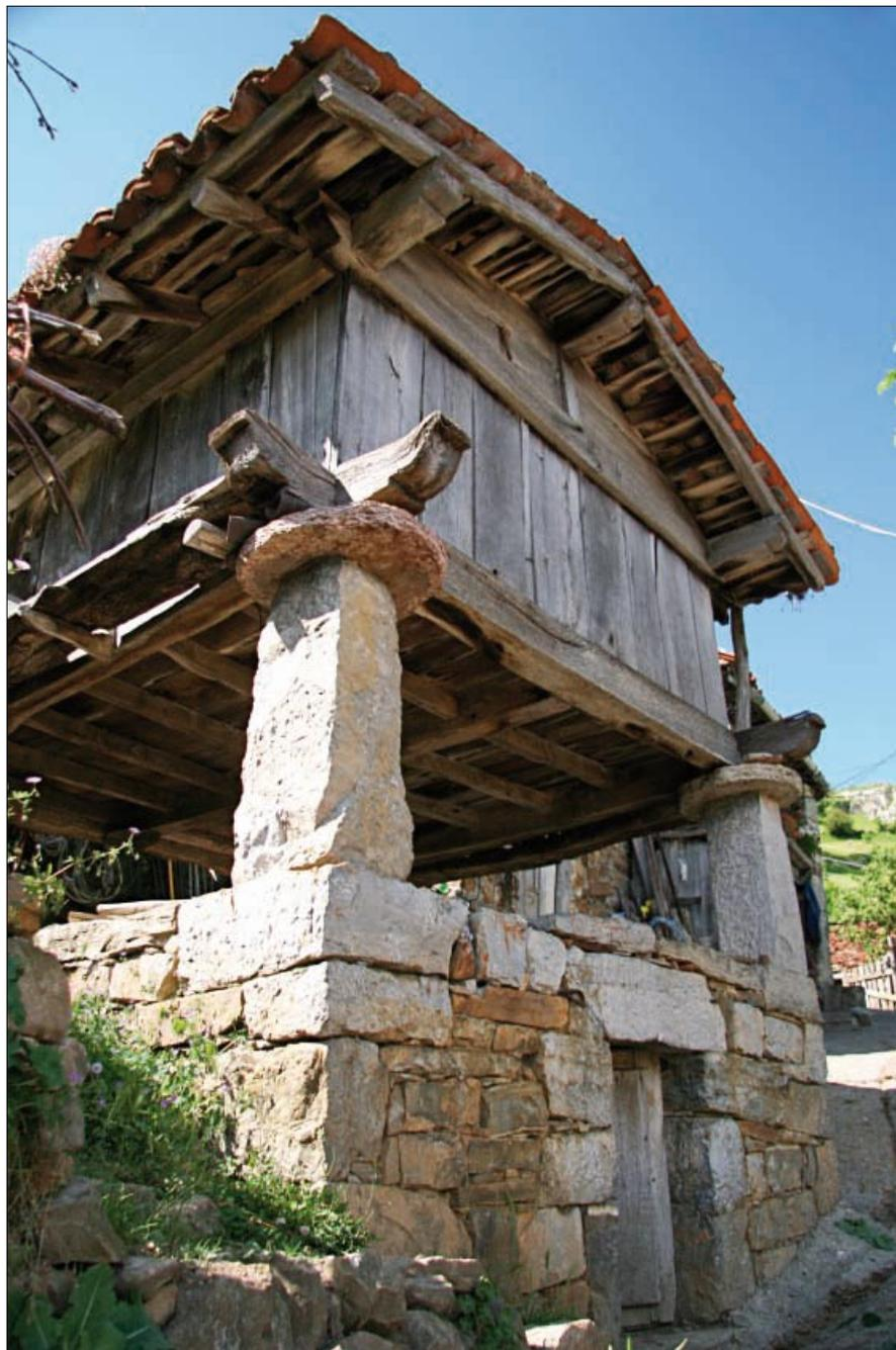
• El hórreo se asienta sobre cuarto dedicado a cubil. Cuatro pegollos calizos de forma prismática y tosca labra apoyan en el muro perimetral y, rematados en pegolleras regularizadas de forma circular, sustentan la cámara. A destacar las testas de las vigas principales (trabes, lliños, cumbrales...) rematadas en molduras sencillas (gola, cuarto de boxel) conocidas popularmente como "pico de pato".
