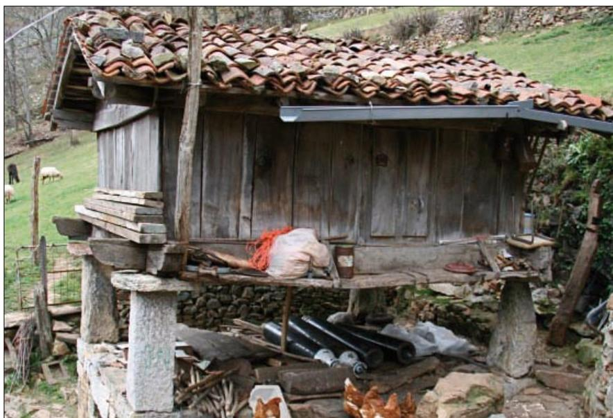
• Vista general del lado NE. Constituye el alzado principal del hórreo, da frente a la casa y es aquí donde se sitúan los elementos de acceso a la cámara: la subidora, de piedra irregular, la tenovia y la única puerta. Resulta evidente el impacto del canalón.
