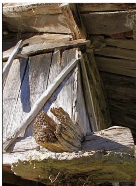
• Detalle de la solución de las esquinas, con cureñes enrasadas reforzadas con charrandhes
