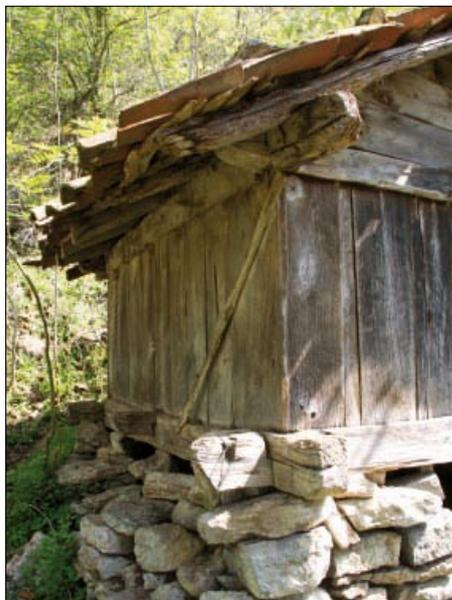
• Detalle de la solución constructiva de la esquina, con cureñas enrasadas y reforzado con darranda.
