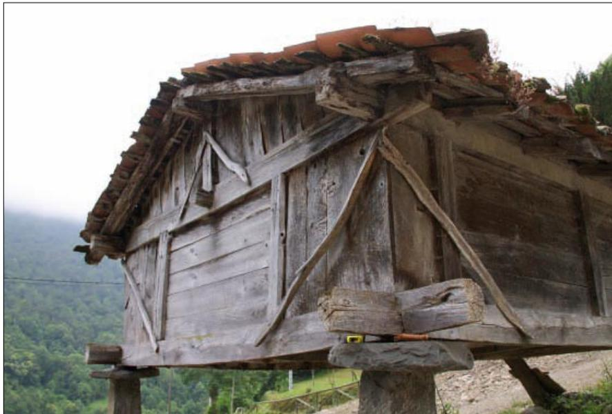
• Los tramos esquineros se resuelven con cureñes verticales, mientras los sectores centrales de cada alzado lo hacen con cureñes horizontales. Como refuerzo estructural utilizan charrandes arrojando las cureñes esquineras a los trabes.
