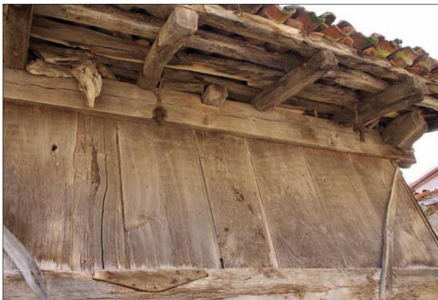
• Detalle de las cureñas del lado NO. Se aprecia la testa de la cruceta, en el centro del lliñu, que perpendicular a la viga cumbreira ata a los dos liños laterales
