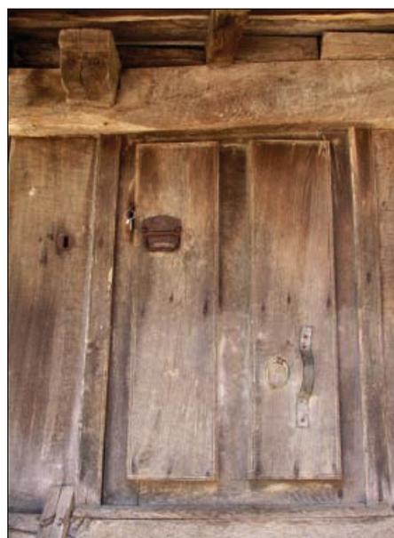
• La única puerta del hórreo, en el lado NE, de sencillo diseño conformado por dos tableros verticales sobre bastidor.
