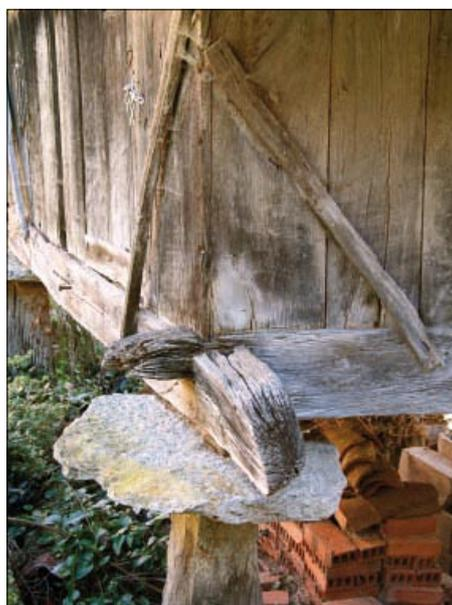
• Un fallo típico: una fenda en el trabemontante provocó el desprendimiento de la parte inferior de la testa.
