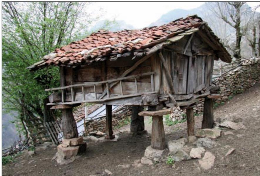
• Otra vista general, lados NE y NO. Situado en terreno con ligera pendiente, los pedreglos asientan sobre pilpayos, bloques pétreos que sirven tanto para lograr la nivelación de la cámara como, para evitar que la humedad del suelo afecte a la madera de los apoyos.
