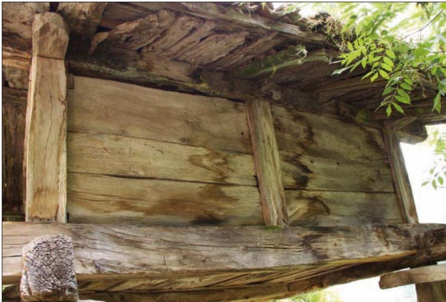
• El lado oeste del hórreo cerrado con cureñes horizontales engarzadas en postes esquineros y parteluz central. Las piezas verticales van ensambladas a caja y espiga en el trabey en el liño.
