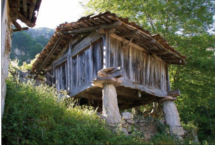
• Vista del hórreo desde la vivienda: la cara sur, rematada en hastial y la cara este. Se aprecia también el enlatao de la cubierta, con siete pares de cabrios de sección variada y algunas de las testas rematadas en sencillas molduras conocidas como "pico de pato".
