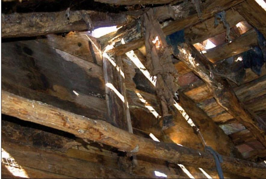
• Detalle interior del hastial de la cara norte. La estructura de cubierta se conforma mediante sendos puntales ensamblados a caja y espiga en los travesales o liños frontales, y en el cumbral o viga cumbre. Los puntales, como en este caso, suelen presentar acanaladuras laterales para recibir las tablas horizontales que, dispuestas a tope, hermetizan el pical o frontón del hórreo.
