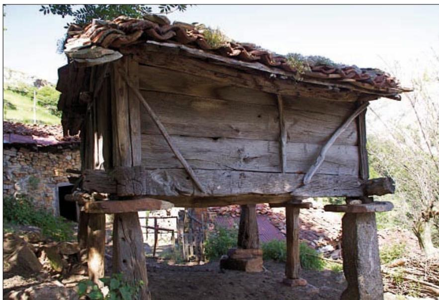
• Detalle del lateral SO del hórreo. En este lado, la cámara o caxal'horrú se cierra con cureñes horizontales colocadas a tope y encajadas en postes esquineros. Muy características son las charrandhes o tablas de arriostamiento que atan las piezas esquineras a los traves.
