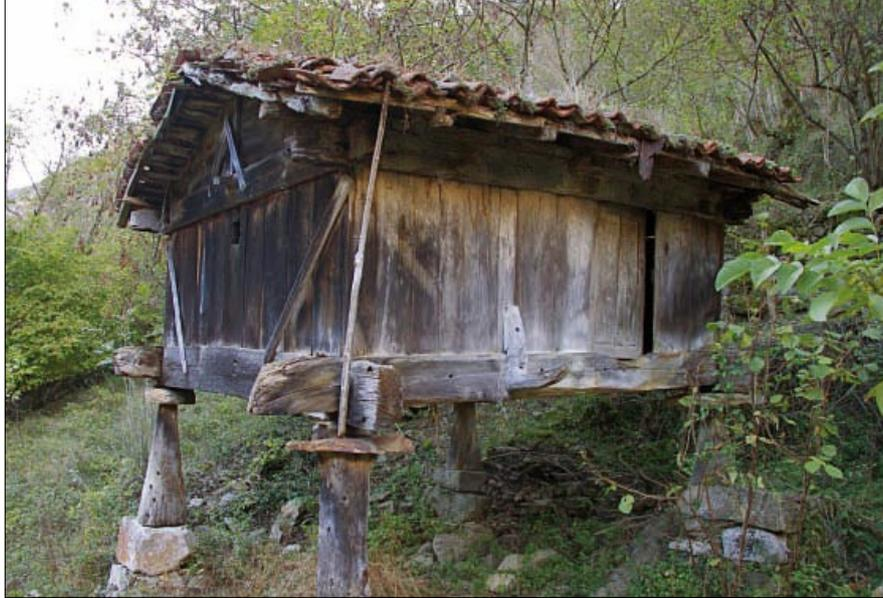
• Vista general del hórreo: el hastial posterior en la cara sur y el lado este, que incluye una de las puertas de acceso. La cámara, cerrada con cureñes verticales, apoya en cuatro pegllos de madera de forma troncopiramidal que descansan sobre pilpayos. Asentado en marcada pendiente, los pegllos presentan diferentes alturas para conseguir la óptima nivelación del hórreo.
