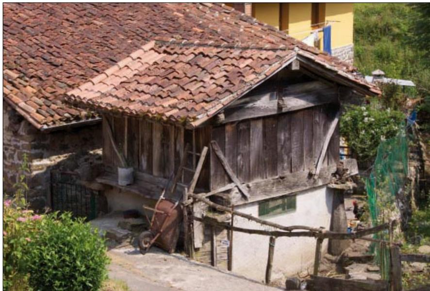
• Vista general con la cara oeste, rematada en frontón, y la cara norte. El hórreo, de reducidas proporciones, fue renovado en época reciente, cambiando parcialmente las tejas de la cubierta y fijándolas con cemento, y hermetizando el solhru entre los pedreglos.
