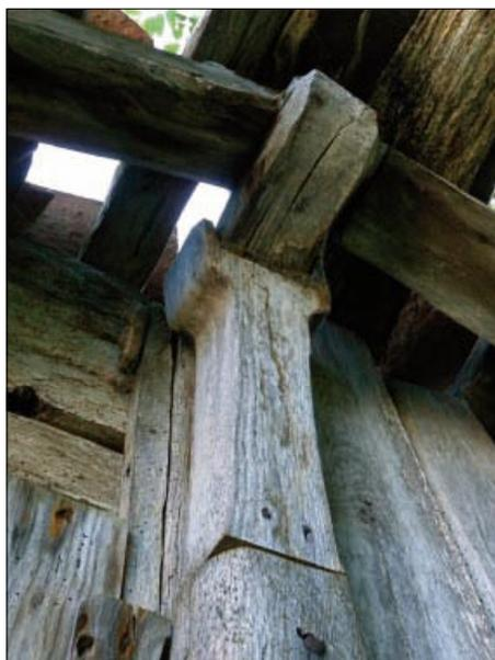
• Frontón de la cara norte. Detalle del puntal exterior ahorquillado, que actúa como refuerzo en el soporte de la viga cumbreira.
