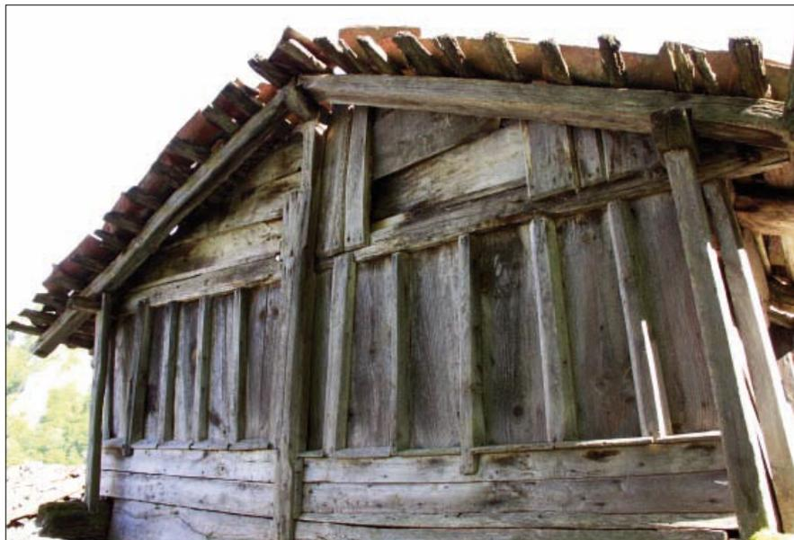
• Detalle del frontón y cerramientos de la cámara en el lado norte. A destacar los mandiles, barrotes clavados a modo de tapajuntas entre las cureñas. También, el puntal central articulado en dos tramos, clavado en el trabe y rematado en horquilla, que sirve de refuerzo de apoyo a la viga cumbreira. Por encima del trabe, se disponen tablas horizontales clavadas que protegen la base de las cureñas de las incidencias atmosféricas.
