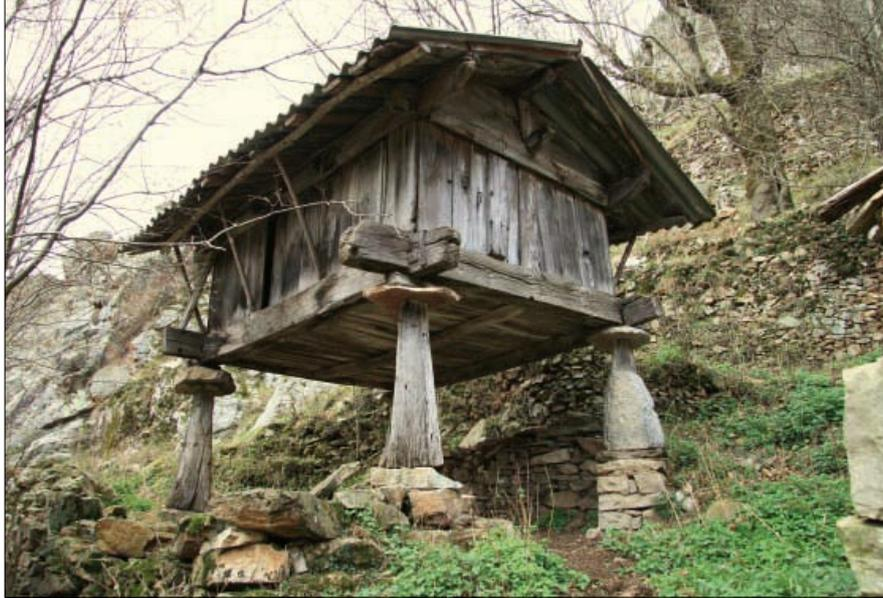
• Vista general del hórreo: el lado NE, rematado en frontón, y el SE. Se apoya en cuatro esbeltos pegollos: tres de madera, de forma troncopiramidal, y uno mixto, de mampostería, piedra y madera, creando un amplio espacio en el solhorru de más de 2 m de altura.
