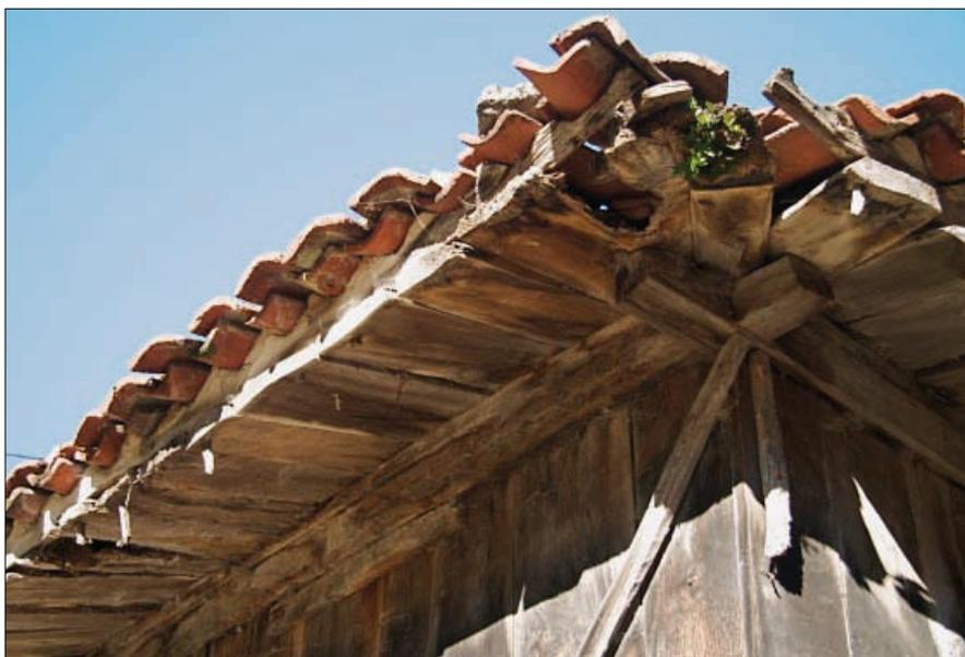
• Detalle de la esquina NE, con la cubierta rematada en aguilón, los cabrios de tabla fijados con tornos de madera y guardamalletas embocando los tejas de canal: elementos característicos del hórreo asturiano tipo. Destacar también el mal estado de la cubierta en ese punto.
