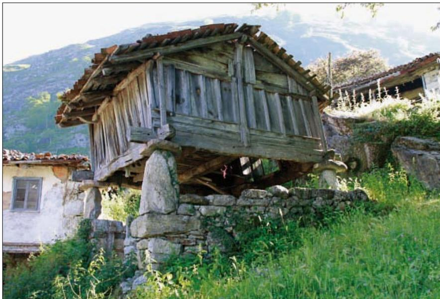
• Vista general del horru de Misés la cara norte, rematada en hastial, y la cara este. Se levanta sobre muro de mampostería que cierra un espacio dedicado a cubil, con acceso en el lado este a través de una cancilla—hoy desmantelada—. Carece de caramanchón. Apoya en cuatro pegollos de piedra caliza de labra muy tosca. Un soviñañu central encajado en los trabesfemeso trabes durmientes, complementado con dos pontones, sirve de refuerzo a un suelo de tablas hoy parcialmente en ruina.
