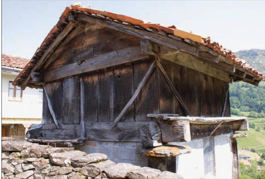
• Vista general del hórreo: caras SO, con el frontón principal, y SE. La cámara se cierra con cureñes verticales engarzadas a peine. En el lado SE se añadió una tenovia que apoyada en las testas de los trabes permite la circulación y su uso como secadero.
