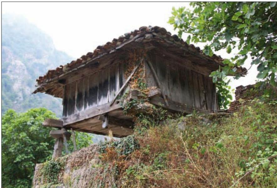
• Vista desde el NE. La cubierta a tres aguas plantea la evolución del hórreo beyusco, con cubierta a dos aguas, al hórreo asturiano tipo, con cubierta a cuatro aguas. En este caso, el remate en faldón de la parte posterior del hórreo ofrece una imagen idéntica a la de un hórreo asturiano.
