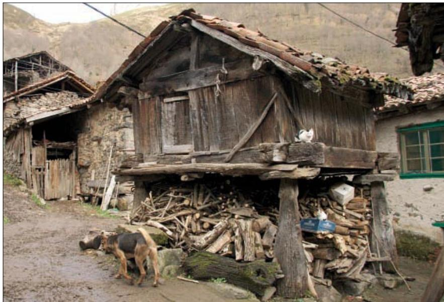
• Vista general del hórreo, lados: SO, rematado en frontón, y SE. La cámara, cerrada con cureñes verticales, se apoya en cuatro pegdlos de madera creando un amplio espacio inferior, el sdhorru, en uso tradicionalmente para almacenamiento de leña.
