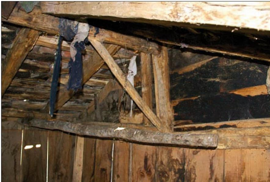
• Detalle interior del hastial de la cara sur. El puntal, aquí de menor entidad, se refuerza mediante contéu o tornapuntas. En ambos extremos, barras de madera suspendidas horizontalmente del cumbral sirven como colgaderos.
