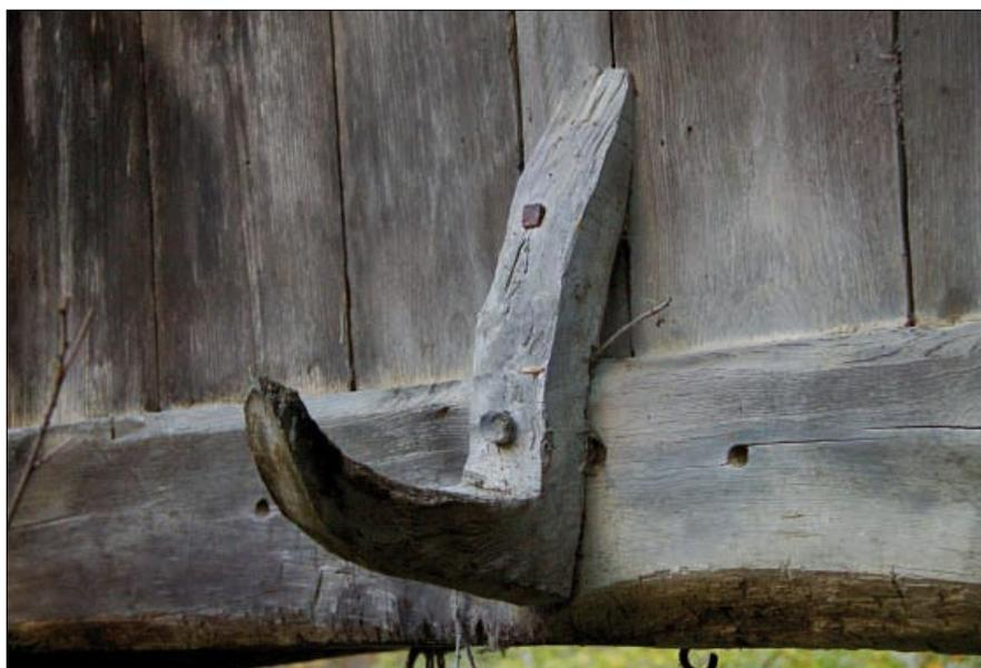
• Soporte de una de las tenovias ya desaparecidas. La tenovia es una tabla horizontal que suele situarse ante la puerta para facilitar el acceso al interior del hórreo; se apoya en soportes de madera fijados con tornos a las paredes del hórreo, como en este caso, o en les peglles.
