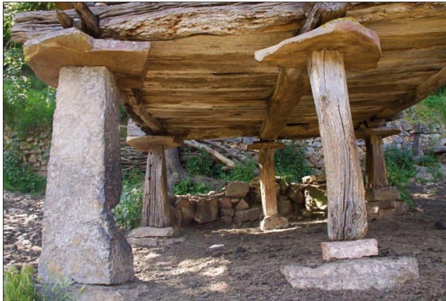
• Detalle del sdhorru. El suelo de pontes, anchos tablonos encajados en los traves durmientes, se refuerza con el sovi gañu o vigapié, viga carcelera que, en este caso, asoma sus testas al exterior apoyándose en dos pegllos de menor entidad a modo de sfitos
