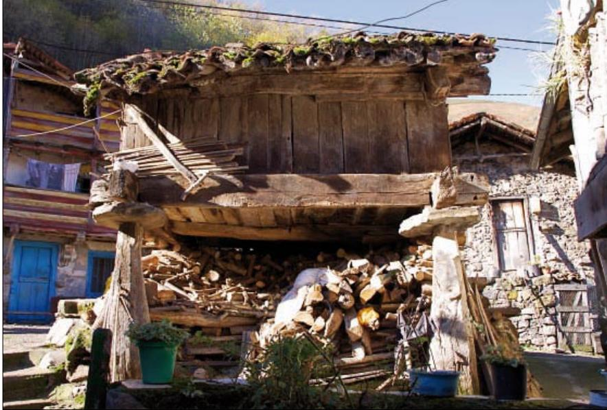
• Fachada SE del hórreo. A destacar, la robustez de las piezas estructurales de la cámara y la escasa altura de las curfies. Es patente también el mal estado de conservación de los aleros.
