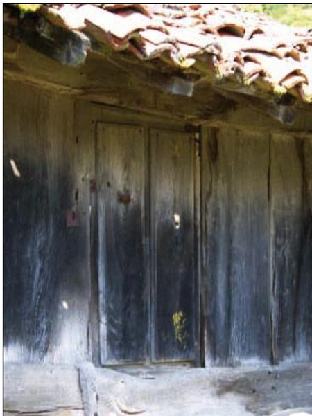
• Puerta en el lado NE, formada por dos tableros gemelos verticales, clavados sobre bastidor.
