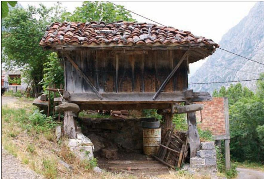
• Vista del costado sur. Se hace patente el perfil de la cubierta, resuelta a tres aguas; las darrandhes o tirantes de arriostramiento para reforzar la cámara y el amplio espacio del solhorr delimitado por un muro perimetral.
