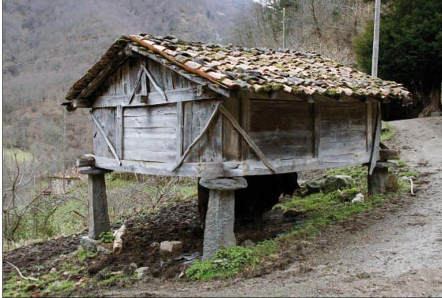
• Vista general con la cara NE, rematada en frontón, y la cara NO. Destaca en este hórreo la solución de los cerramientos de la cámara con el uso mixto de cureñes horizontales y verticales.
