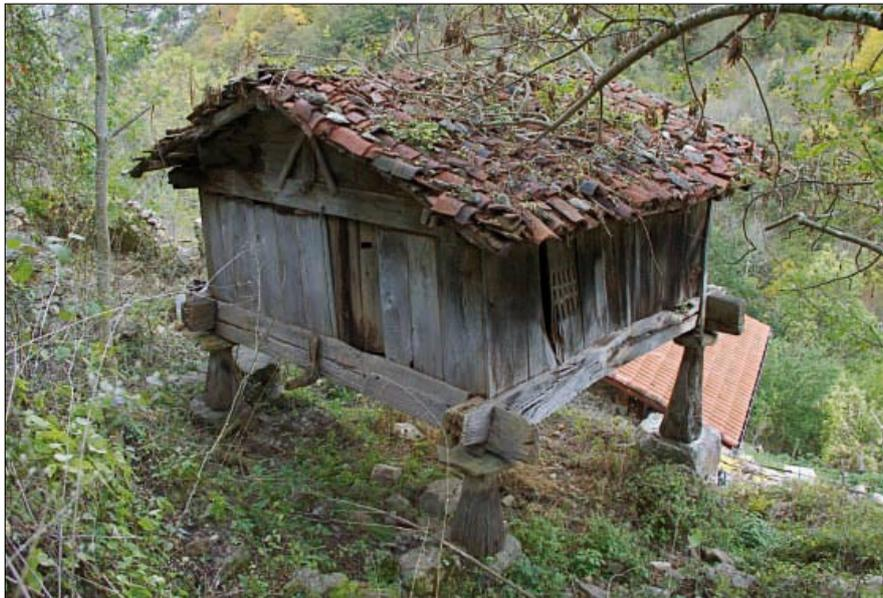
• Lado norte del hórreo con el hastial frontal y lado oeste. La cubierta, de teja del país colocada en seco y afianzada con pequeñas piedras, presenta muy mal estado de conservación, especialmente en los aleros. Actualmente el hórreo está abandonado.
