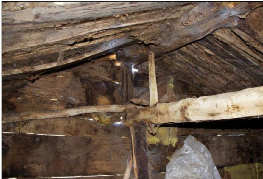
• Detalle interior del hastial de la cara SE. La estructura de cubierta se conforma mediante sendos puntales ensamblados a caja y espiga en los liños frontales, y en el cumbral o viga cumbre. Los puntales suelen presentar acanaladuras laterales para recibir las tablas horizontales que, dispuestas a tope, hermetizan el pical o frontón del hórreo.
