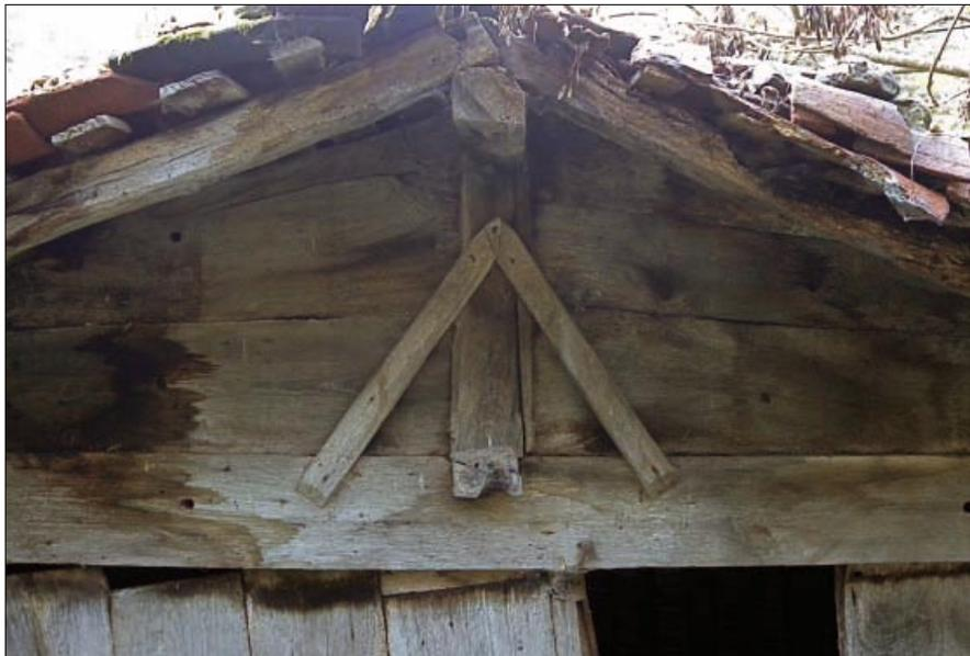
• Cara norte. Un puntal de sección rectangular, encajado a caja y espiga en la cruceta y en la viga cumbreira, estructura en este lado la cubierta. Presenta acanaladuras laterales donde encajan las tablas horizontales que hermetizan el frontón o pical del hórreo. En este caso, el puntal se refuerza mediante dos tirantes, atándolo al travesal o liño frontal.
