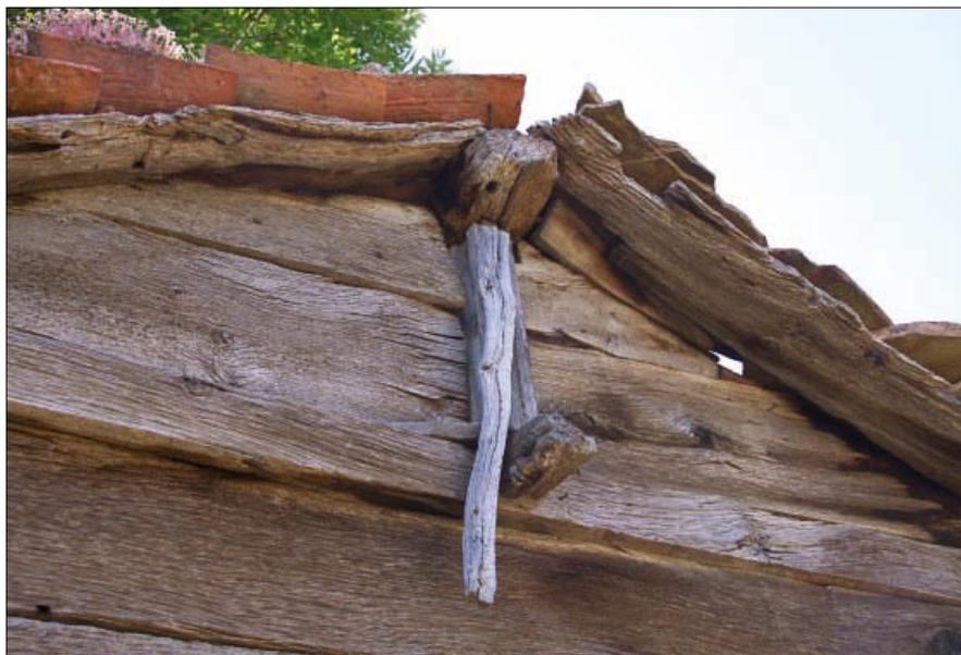
• Detalle del pical o frontón del hórreo. La estructura de cubierta más común en estos hórreos consiste en sendos puntales ensamblados a caja y espiga en la cruzeta, viga que ata los travesales o liños frontales, y en la viga cumbreira.
