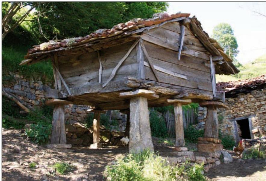
• Vista general del hórreo, lados SO, y SE con el frontón posterior. Seis pegdlos cinco de madera y uno de piedra caliza toscamente es cuadrado, sirven de apoyo a la cámara. Ésta se estructura en cuatro postes esquineros, con cerramiento de cureñes horizontales en tres de sus lados.
