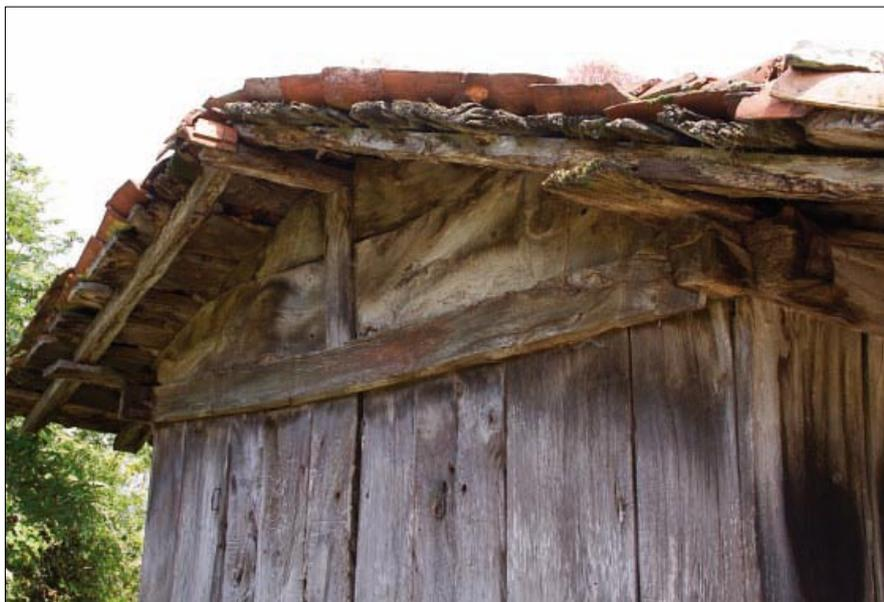
• Detalle del pical o frontón de la cara NO. A destacar el vuelo de las testas de la viga cumbreira y de los liños laterales, que permiten la proyección de la cubierta, protegiendo el frente del hórreo de las inclemencias.
