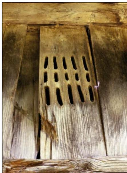
• Cureña con perforaciones para ventilación en el lado oeste. Se sitúa en línea con la puerta del lado opuesto, para favorecer la circulación del aire en el interior de la cámara.
