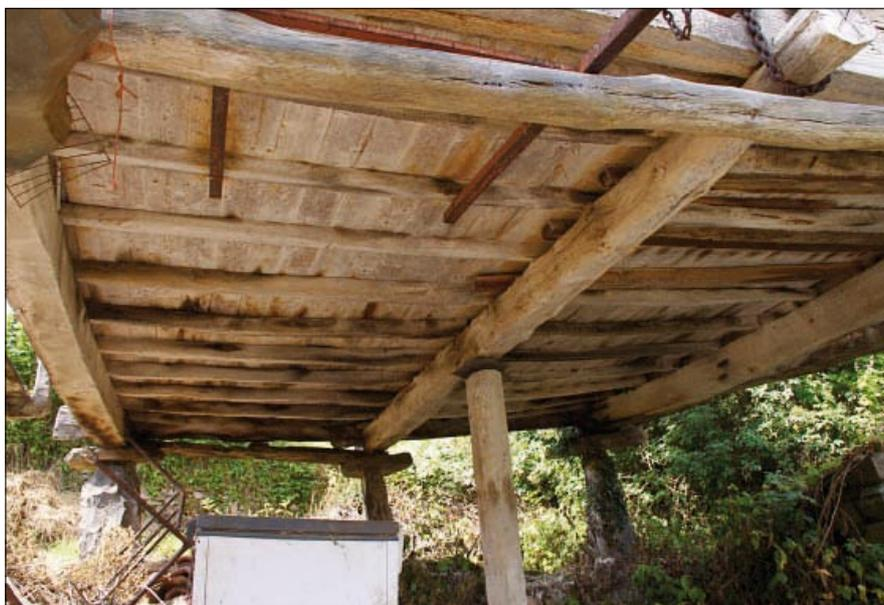
• Solado del hórreo de tillu (pontoncillo y tabla) con vigapié central. Éste encaja en los trabes por su parte inferior mostrando las testas voladas y cuenta, además, con apoyos de refuerzo: pegdlu, pie derecho central y atado.
