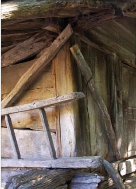
• Esquineru norte. De sección cuadrangular o en "L", los esquineros van ensamblados a caja y espiga en los traves montantes y en los travesales o liños frontales.
