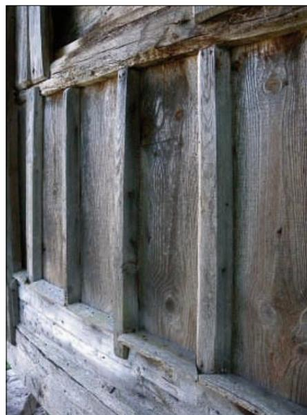
• Cara norte. Detalle de las cureñas o tablas verticales que cierran la cámara y los mandiles con tornaguas intermedios para evitar filtración de humedades.
