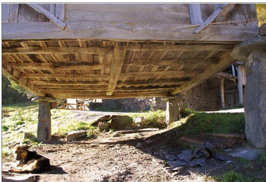
• Detalle del solado del hórreo, resuelto con tillu —tabla y pontoncillo— y svigañu central paralelo a la viga cumbreira. Éste va ensamblado con encaje ciego en los traves montantes.
