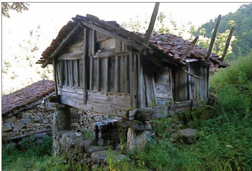
• Una toma semejante, en 2013, nos revela la rotura del lliñu oeste y el incipiente hundimiento de la cámara en ese lado, lo que causó el movimiento de las tejas de cubierta y el desplazamiento de algunas cureñas, situando la construcción al borde del colapso estructural.
