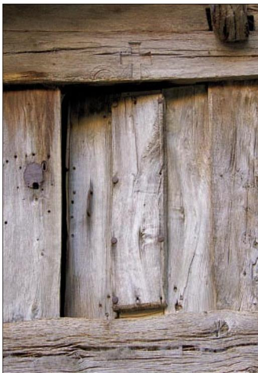
• La puerta original del hórreo, en el lado NE. Construida con dos grandes tablones verticales y ancho montante central fijado con clavos de forja.
