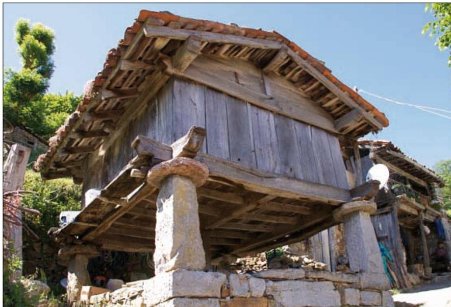
• Vista general del hórreo: lado SE, rematado en frontón, y lado SO. La cámara se cierra en sus cuatro caras con cureñes verticales, que aparecen clavadas en los encuentros esquineros. Los frontones, en ambos lados, se hermetizan con tablas dispuestas horizontalmente.
