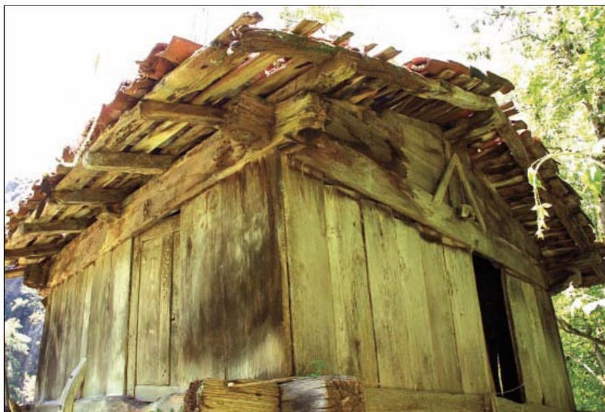
• Siete cabrios por cada lado, apoyados en la viga cumbre y en los sobreliños, conforman las aguadas de la cubierta. En la imagen se aprecia el deterioro de los bistechos o aleros, así como las cureñes del lado norte con las testas desencajadas del liño por desplazamiento horizontal de la cámara.
